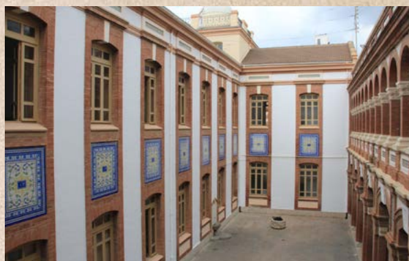
Segundo patio interior, lado oeste
