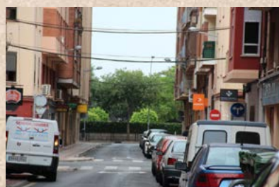
Final de la calle junto a la Avenida de Burriana
