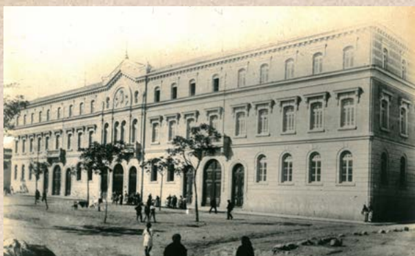
Fachada exterior del Instituto Ribalta, vista desde el norte (postal antigua)
