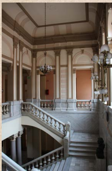
Escalinata segundo tramo lado oeste
