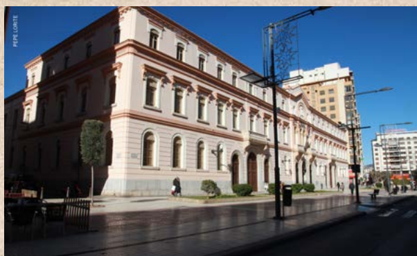
Fachada principal vista desde el lado sur
