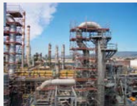
Montaje y alquiler de andamios
