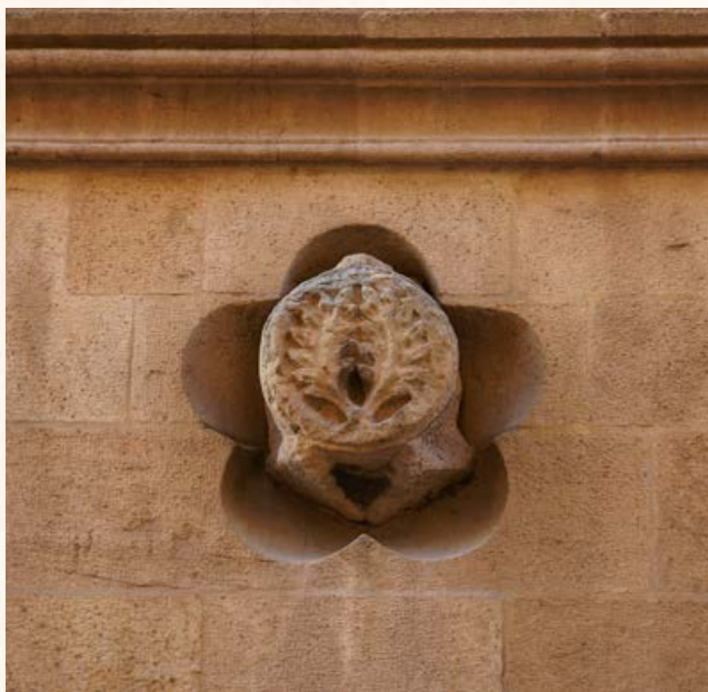
La palma del martirio (fachada meridional) Clave de arco rescatado entre los escombros del derribo de la iglesia
