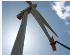
Reparación de palas en aerogeneradores
