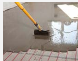
Reparación de hormigón
